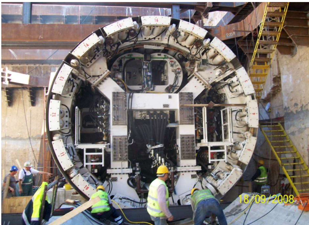
ΣΥΝΑΡΜΟΛΟΓΗΣΗ ΜΕΤΑΛΛΙΚΩΝ ΑΝΤΙΣΤΗΡΙΞΕΩΝ ΚΑΙ ΣΥΝΑΡΜΟΛΟΓΗΣΗΣ ΜΕΤΡΟΠΟΝΤΙΚΑ ΣΤΟ ΜΕΤΡΟ ΘΕΣΣΑΛΟΝΙΚΗΣ, ΟΠΩΣ ΚΑΙ ΤΗΝ ΠΡΩΘΗΣΗ ΤΟΥ
