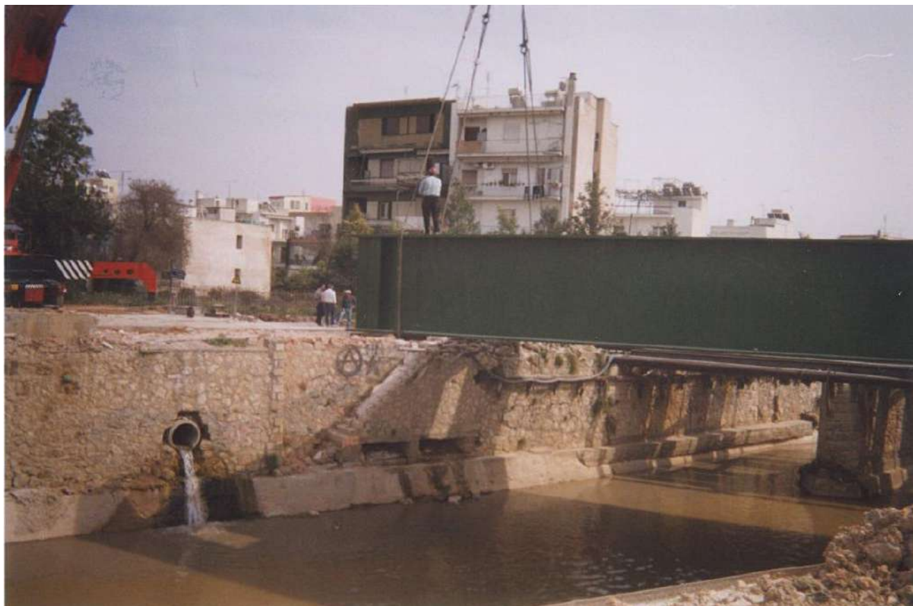
ΣΥΝΑΡΜΟΛΟΓΗΣΗ ΓΕΦΥΡΑΣ ΚΑΙ ΑΝΕΛΚΥΣΗ ΑΥΤΗΣ ΓΙΑ ΛΟΓΑΡΙΑΣΜΟ ΤΟΥ ΗΣΑΠ ΣΤΟ ΠΟΤΑΜΙ ΤΟΥ ΚΗΦΙΣΟΥ 300ΤΝ
