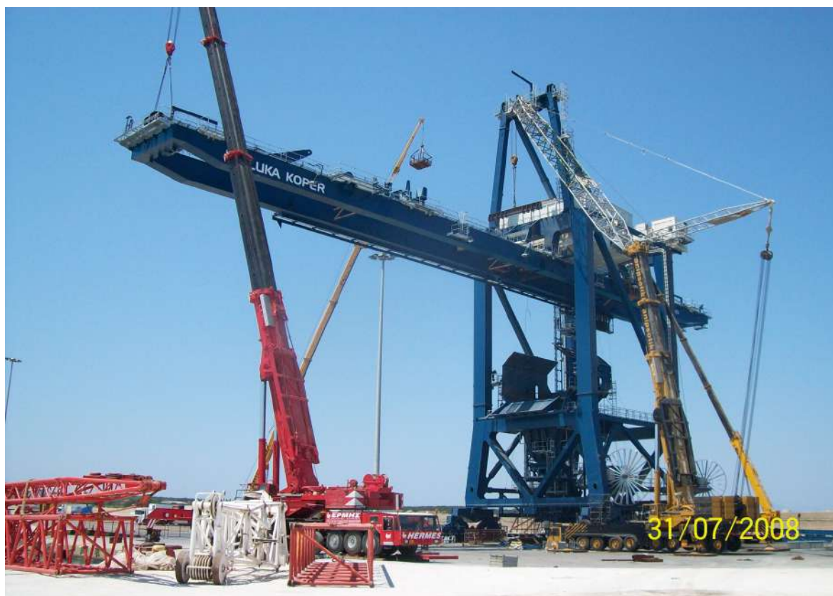
ΣΥΝΑΡΜΟΛΟΓΗΣΗ ΕΝΟΣ ΓΕΡΑΝΟΥ ΣΤΟ ΛΙΜΑΝΙ ΤΗΣ ΚΥΛΛΗΝΗΣ ΝΟΜΟ ΗΛΙΑΣ ΕΧΕΙ ΑΝΕΚΛΥΘΕΙ ΕΠΑΝΩ ΣΕ ΠΛΩΤΗ ΜΠΑΡΤΣΑ ΜΕΤΑΦΟΡΑ ΣΤΗ ΣΛΟΒΕΝΙΑ ΚΑΙ ΑΝΤΙΣΤΡΟΦΩΣ ΜΕ ΤΟΝ ΙΔΙΟ ΤΡΟΠΟ ΕΧΕΙ ΑΝΕΚΛΥΘΕΙ ΑΠΟ ΤΗΝ ΠΛΩΤΗ ΜΠΑΡΤΣΑ ΕΠΑΝΩ ΣΤΙΣ ΡΑΓΕΣ ΚΑΙ ΜΠΡΟΣΤΑ ΣΤΟ ΛΙΜΑΝΙ ΤΗΣ ΣΛΟΒΕΝΙΑΣ. ΒΑΡΟΣ 2500ΤΝ.
