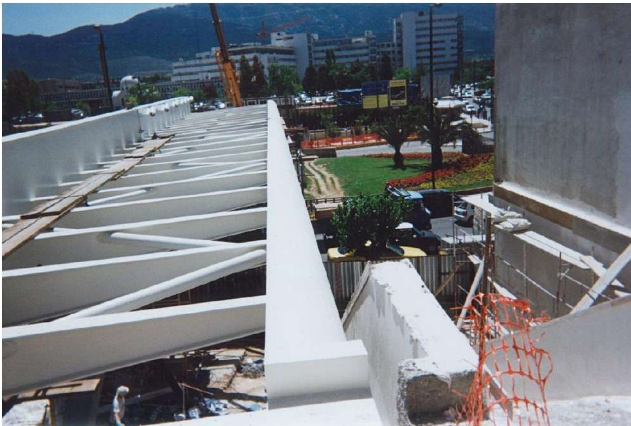
ΑΝΕΓΕΡΣΗ ΠΕΖΟΓΕΦΥΡΑΣ ΤΥΠΟΥ ΑΡΠΑ ΜΕΤΑΞΥ ΤΗΣ ΟΔΟΥ ΜΕΣΟΓΕΙΩΝ ΚΑΙ ΚΑΤΕΧΑΚΗΣ. ΕΞΥΠΗΡΕΤΗΣΗ ΠΕΖΩΝ ΣΤΗΝ ΣΤΑΣΗ ΤΗΣ ΚΑΤΕΧΑΚΗΣ ΤΟΥ ΜΕΤΡΟ. ΒΑΡΟΣ 800ΤΝ.
