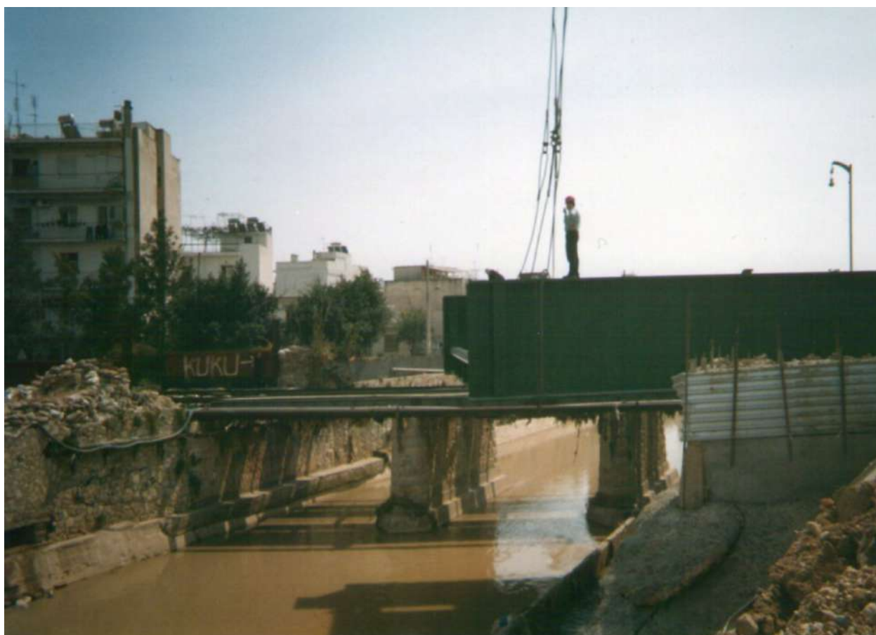
ΣΥΝΑΡΜΟΛΟΓΗΣΗ ΓΕΦΥΡΑΣ ΚΑΙ ΑΝΕΛΚΥΣΗ ΑΥΤΗΣ ΓΙΑ ΛΟΓΑΡΙΑΣΜΟ ΤΟΥ ΗΣΑΠ ΣΤΟ ΠΟΤΑΜΙ ΤΟΥ ΚΗΦΙΣΟΥ 300ΤΝ
