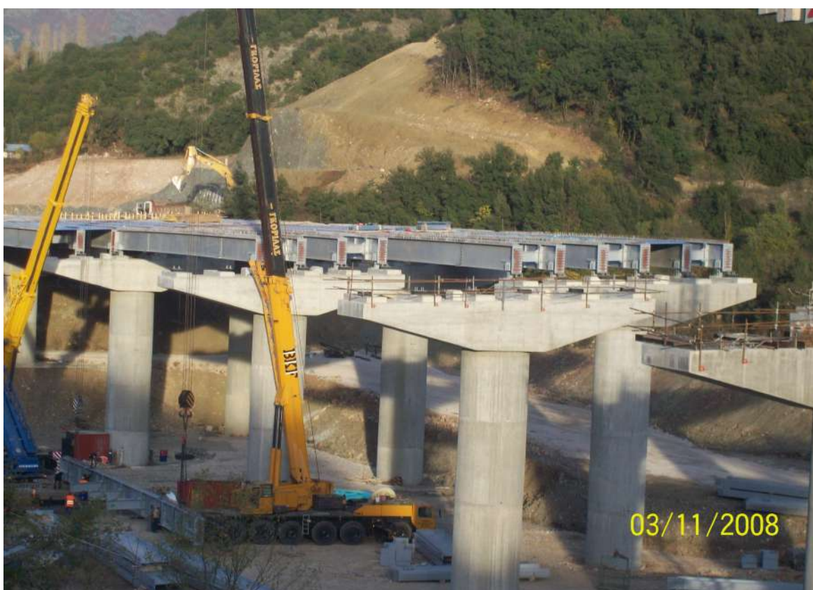
ΑΝΕΓΕΡΣΗ ΓΕΦΥΡΑΣ ΣΤΗΝ ΕΓΝΑΤΙΑ ΟΔΟ ΚΑΤΑ ΜΗΚΟΣ. ΒΑΡΟΣ 5.000ΤΝ
