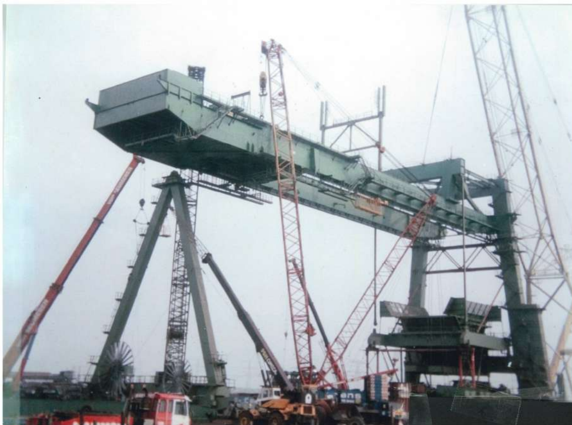
ΣΥΝΑΡΜΟΛΟΓΗΣΗ ΕΝΟΣ ΓΕΡΑΝΟΥ ΣΤΟ ΛΙΜΑΝΙ ΤΟΥ ROTTERDAM ΤΗΣ ΟΛΛΑΝΔΙΑΣ ΜΕΤΑ ΤΟ ΠΕΡΑΣ ΤΩΝ ΕΡΓΑΣΙΩΝ ΕΓΙΝΕ ΠΡΩΘΗΣΗ ΣΤΗΝ ΘΕΣΗ ΤΟΥ ΒΑΡΟΥΣ 4.500ΤΝ
